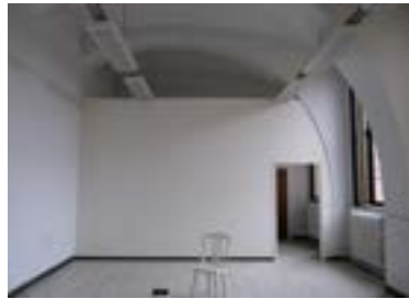
Westvleugel, eerste verdieping.
