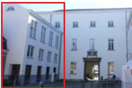
Nieuwbouw oostvleugel, stadhuis.
