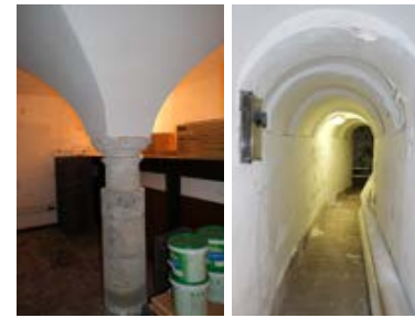
Oostvleugel, kelder nr. 1a en 2.
