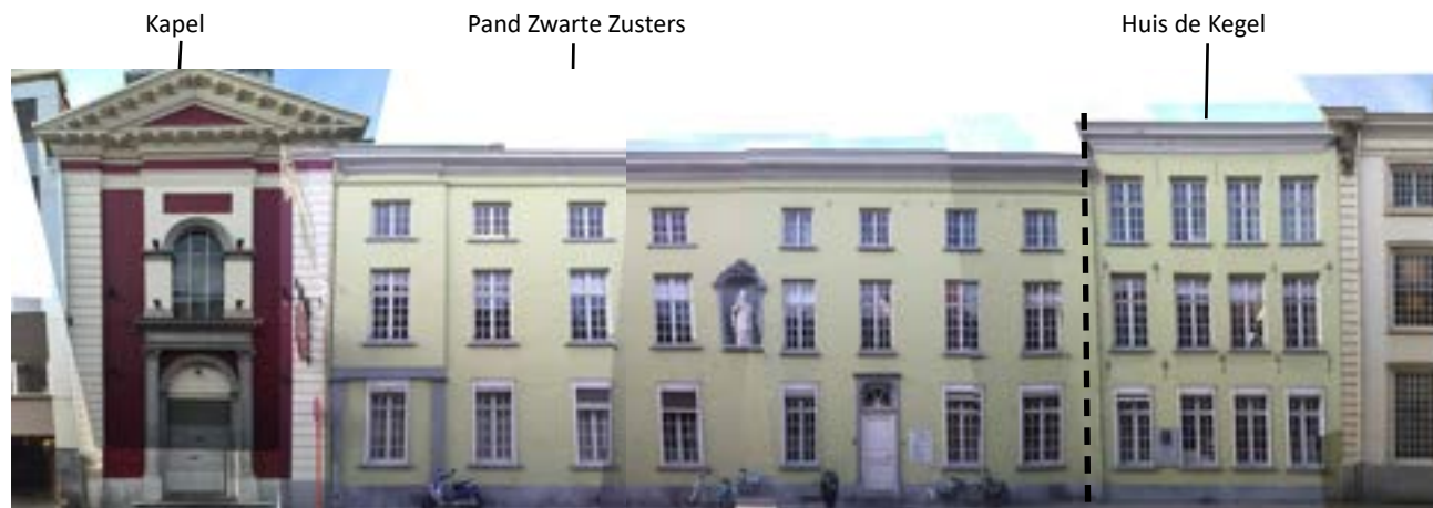
Voorgevel voormalig klooster van de Zwarte Zusters, straatkant Zwarte Zustersstraat © Panorama uit DE JAEGER, I., Stadhuissite te Aalst: Historische analyse, waardestelling en herbestemmingsontwerp , Masterthesis KU Leuven, 2016.
