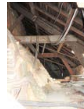
2021: Huidige toestand dakgebinte met gewelf en lichtkoker van de overkapping.
