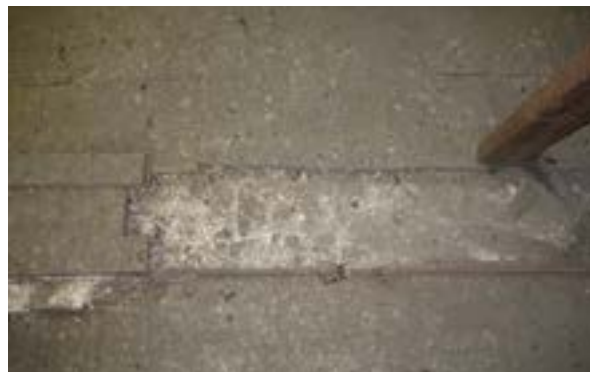
Bouwspoor van een gesloopte bakstenen topgevel, zolder.
