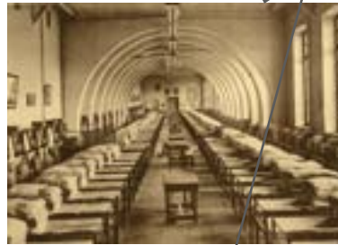
Westvleugel, eerste verdieping 'slaapzaal'.
