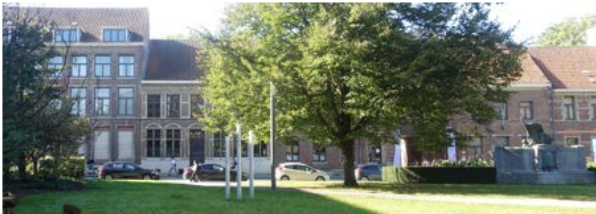
Huidige (afgestripte) gevels - na restauratie van de Regie der gebouwen
