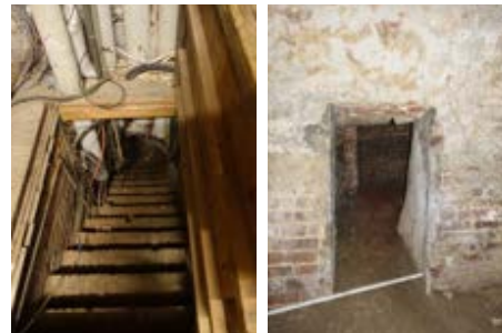
Links: kelder A, keldertrap Rechts: keldertoegang tussen kelder A en B
