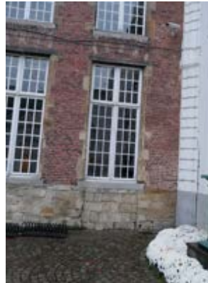
Bouwnaden in zandstenen plint van vroegere deuropening, gedicht met recuperatie zandstenen.
