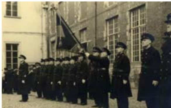
Foto van de brandweer omstreeks 1950, vooraf bepleistering verbouw volume van De Trilles en dichtgemetseld vensters op de eerste verdieping.
