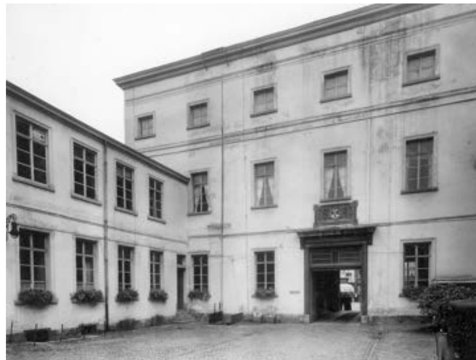
1945: Foto van nieuwe aanbouw aan noordvleugel van het stadhuis © KIK-IRPA.
