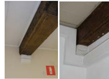
Oostvleugel, 1ste verdieping, nr. 1a.
