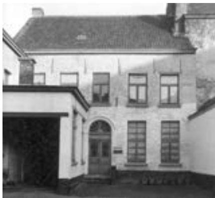
Nr. 1a, achtergevel
