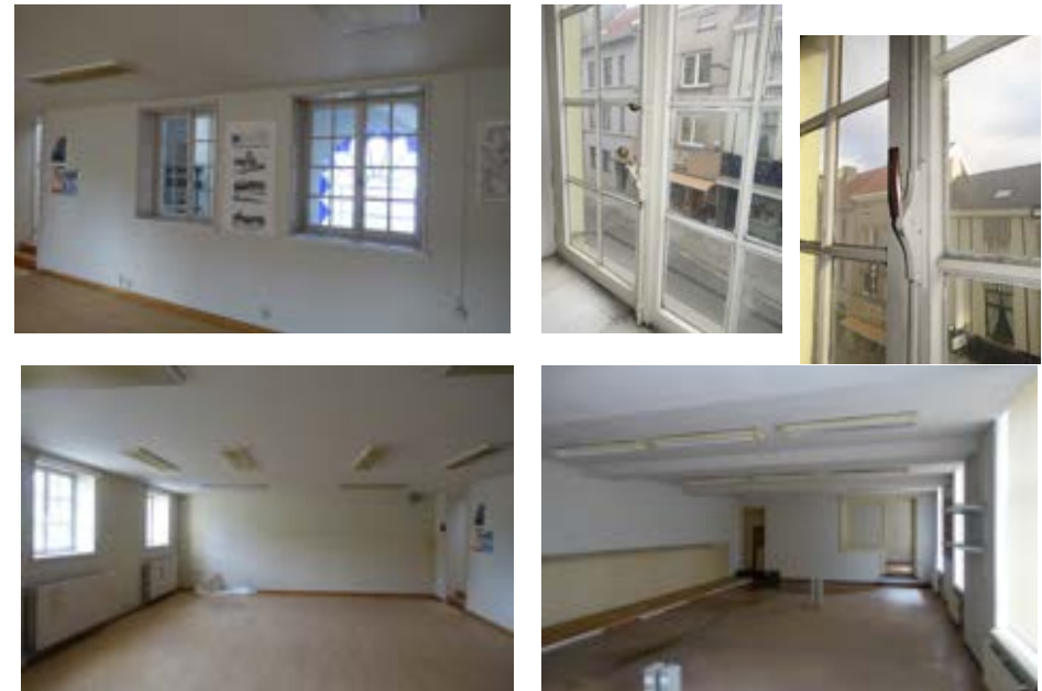
Gerenoveerde kamers met vernieuwde vloerbekleding, verlaagd plafond maar behouden schrijnwerk van vensters.
