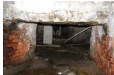
Vernieuwde toegang tussen kelder C en B
