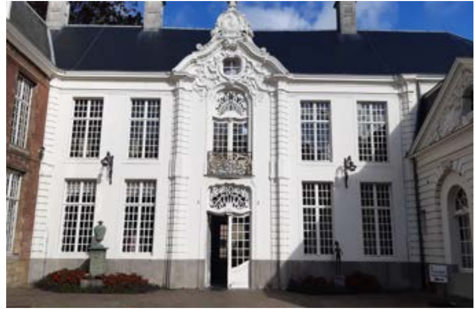
Stadhuis, noordvleugel voorgevel.
