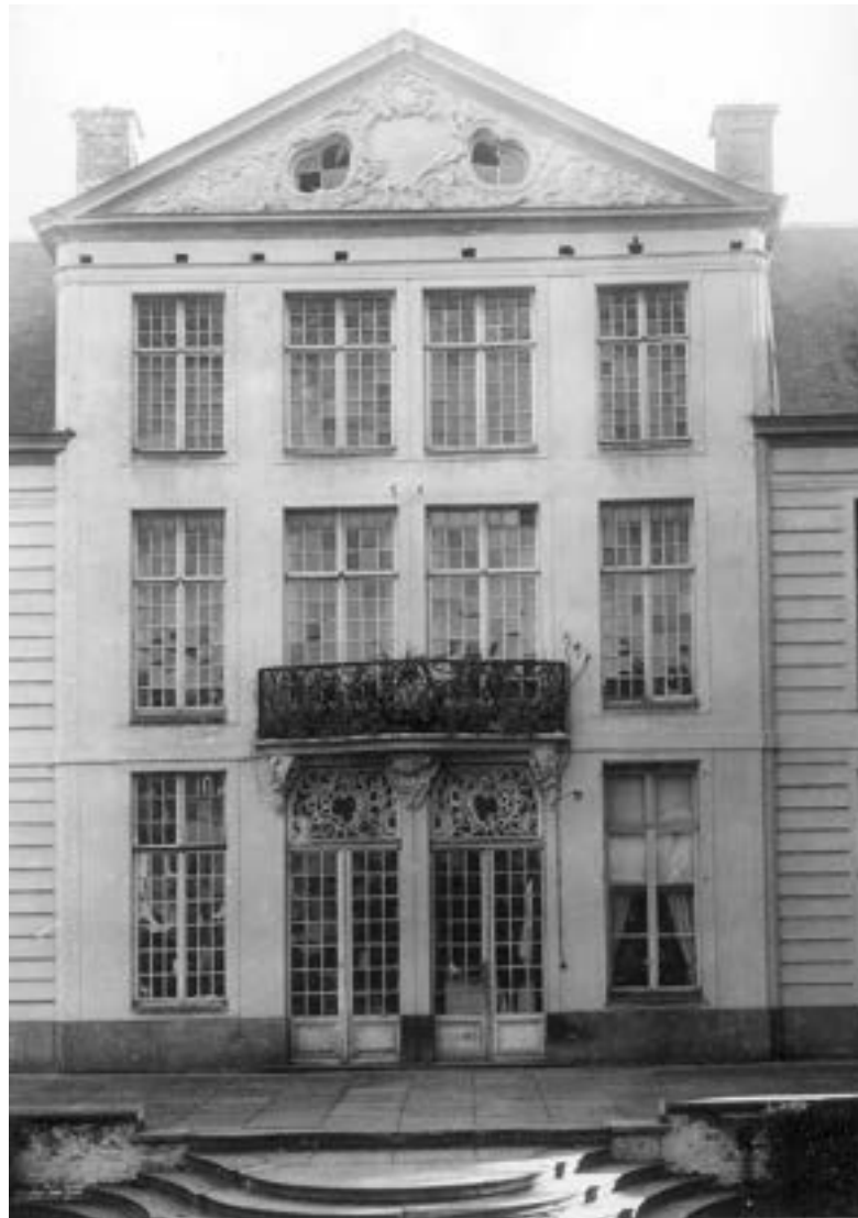
1945: tuingevel van de noordvleugel, met nog authentiek schrijnwerk en beglazingen © KIK-IRPA, Brussel.
