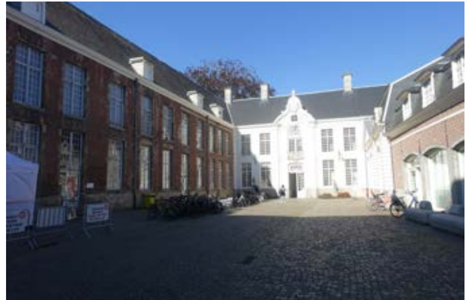
Stadhuis, binnenkoer met zicht op noordvleugel
