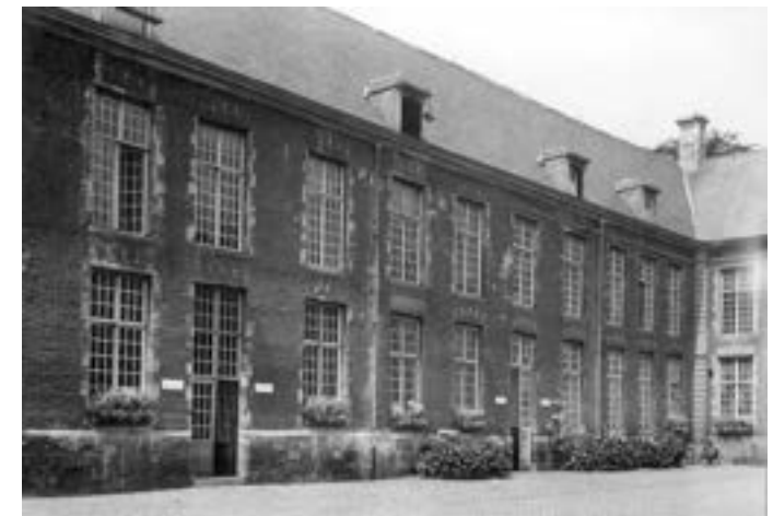
Foto 1942: westvleugel, voormalige hoofdzetel van het Land van Aalst © KIK-IRPA.
