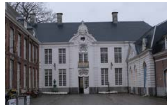
2021: Binnenkoer met zicht op noordvleugel, huidige toestand.
