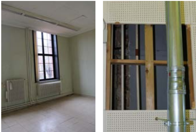
Verlaagde plafonds met boven originele troggewelven
