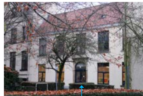
Nr. 3, achtergevel met barokke zandstenen omlijsting.
