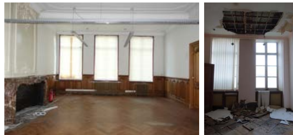
Interieurfwerking voormalig kloosterpand
