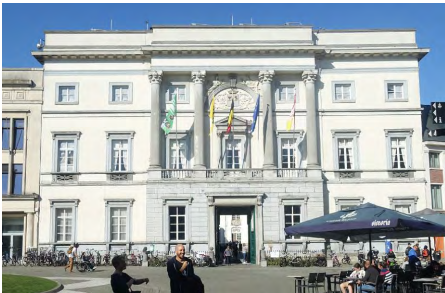
Stadhuis aan Grote Markt, voorgevel zuidvleugel
