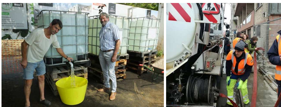
Figuur 78. Hergebruik van bemalingswater: via opslagtanks in Nevele (links, bron: HLN) en vullen van veegwagens in Brussel (rechts, bron: OpenSource Brussels).
