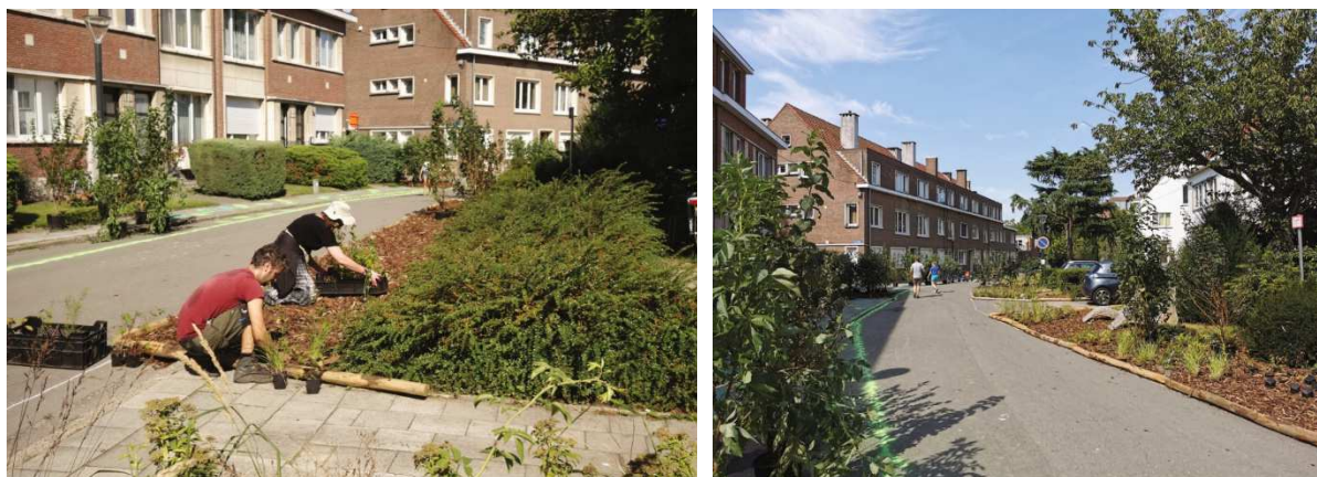
Figuur 75. Proefopstelling ontharding Redingenhof Leuven (bron: 51N4E)
