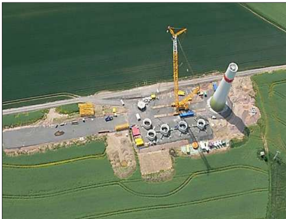
Figuur 16 : Kraanplatform
