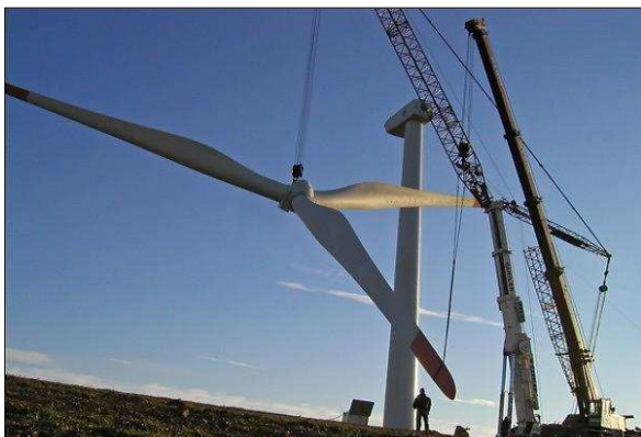
Figuur 14 : Plaatsing hub met wieken
