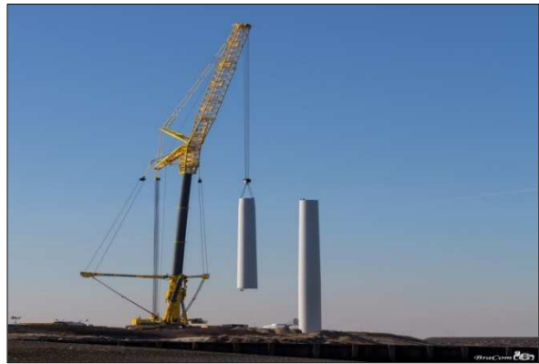
Figuur 13 : Bouw mast windturbine
