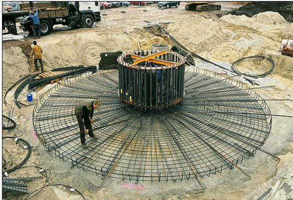
Figuur 12 : Fundering windturbine
