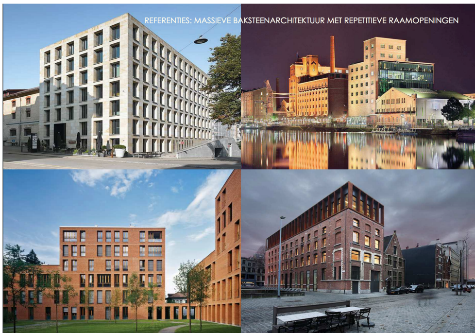
Figuur 3: Massieve architectuur met repetitieve raamopeningen en inpandige terrassen.
