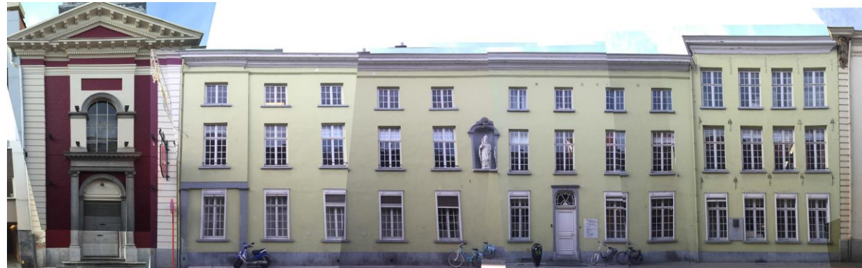
Voormalig klooster van de Zwarte Zusters met kapel (links) en Huis de Kegel (rechts); voorzijde Zwarte Zustersstraat
