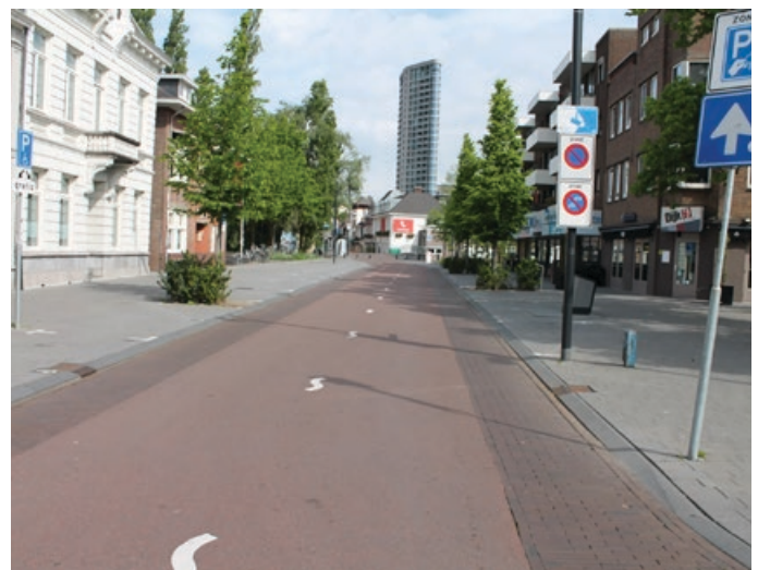
In fietsstraten is het wegprofiel geoptimaliseerd voor fietsers. Autoverkeer wordt afgeremd en gedestimuleerd. (links: fietsstraat Oss; rechts: fietsstraat slowlane Eindhoven)
