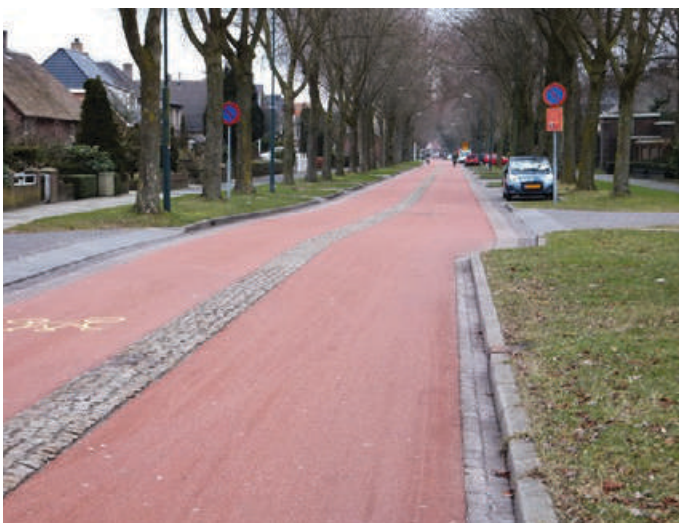
In fietsstraten is het wegprofiel geoptimaliseerd voor fietsers. Autoverkeer wordt afgeremd en gedestimuleerd. (links: fietsstraat Oss; rechts: fietsstraat slowlane Eindhoven)
